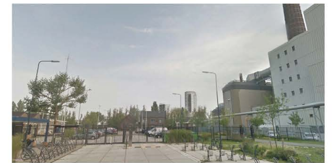
Zicht vanaf de energiecentrale
